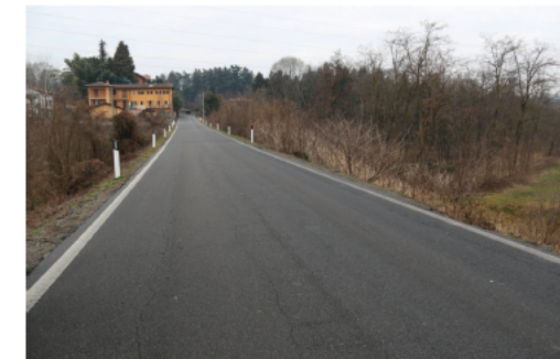
la strada comunale per Oleggio Castello in rilevato
